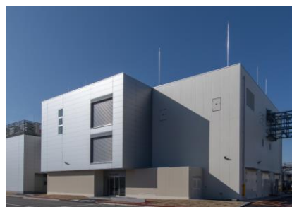
第3実験棟（小山工場内）
